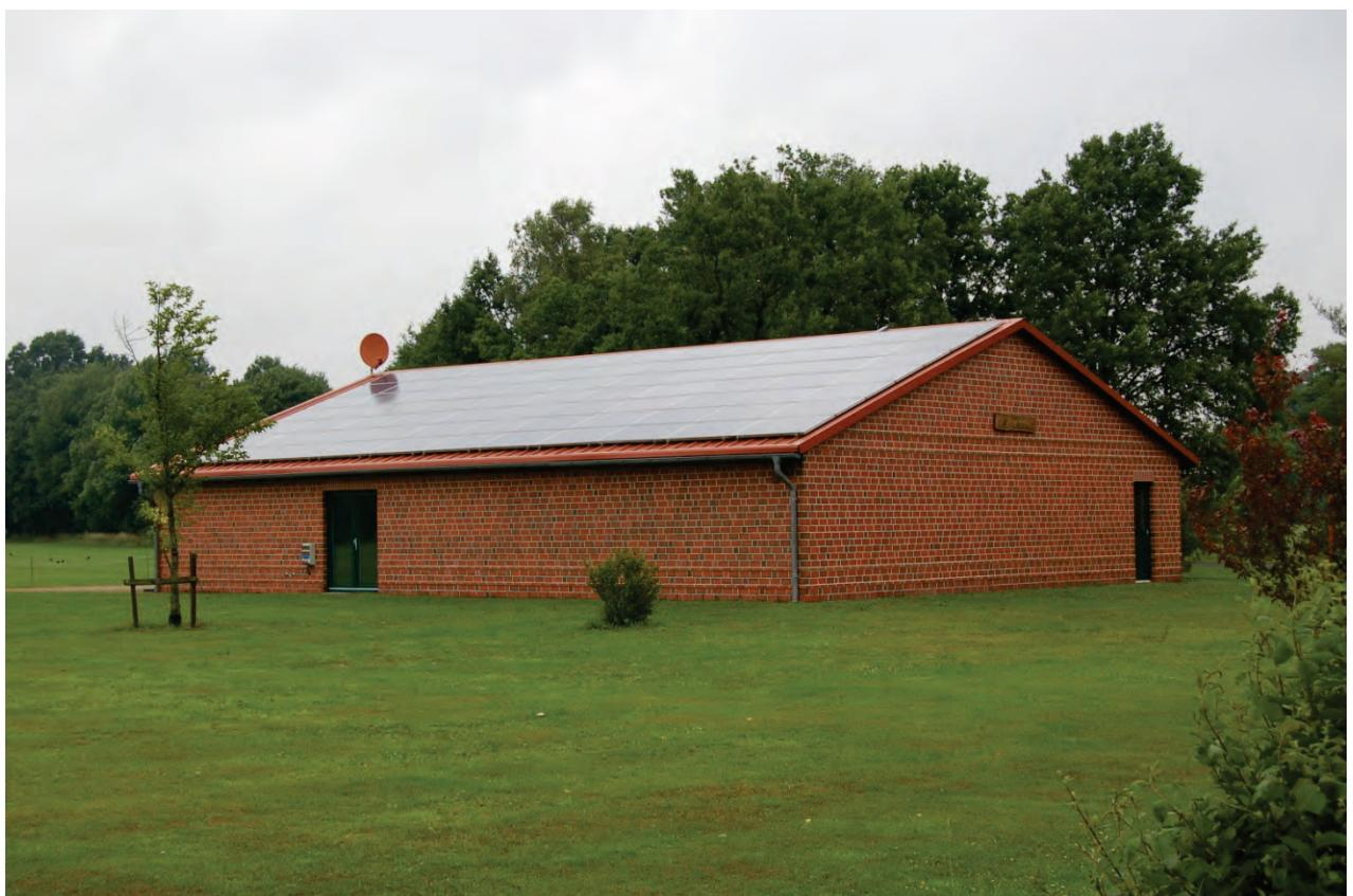
Das Dach des Schützenhauses ist nun seit 2012 mit einer Solaranlage versehen. Die Leistung beträgt 27.49 KWp wird mit einer Solarmodulfläche 192 qm erzeugt. Die Anlagentechnik konnte ohne großen Aufwand in Nebenräumen des Schützenhauses untergebracht werden.
