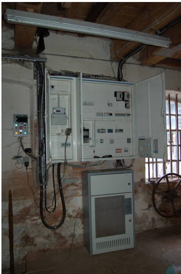
Elektrischer Schaltschrank: von hier wird der erzeugte Strom in das Stromnetz eingespeist.
