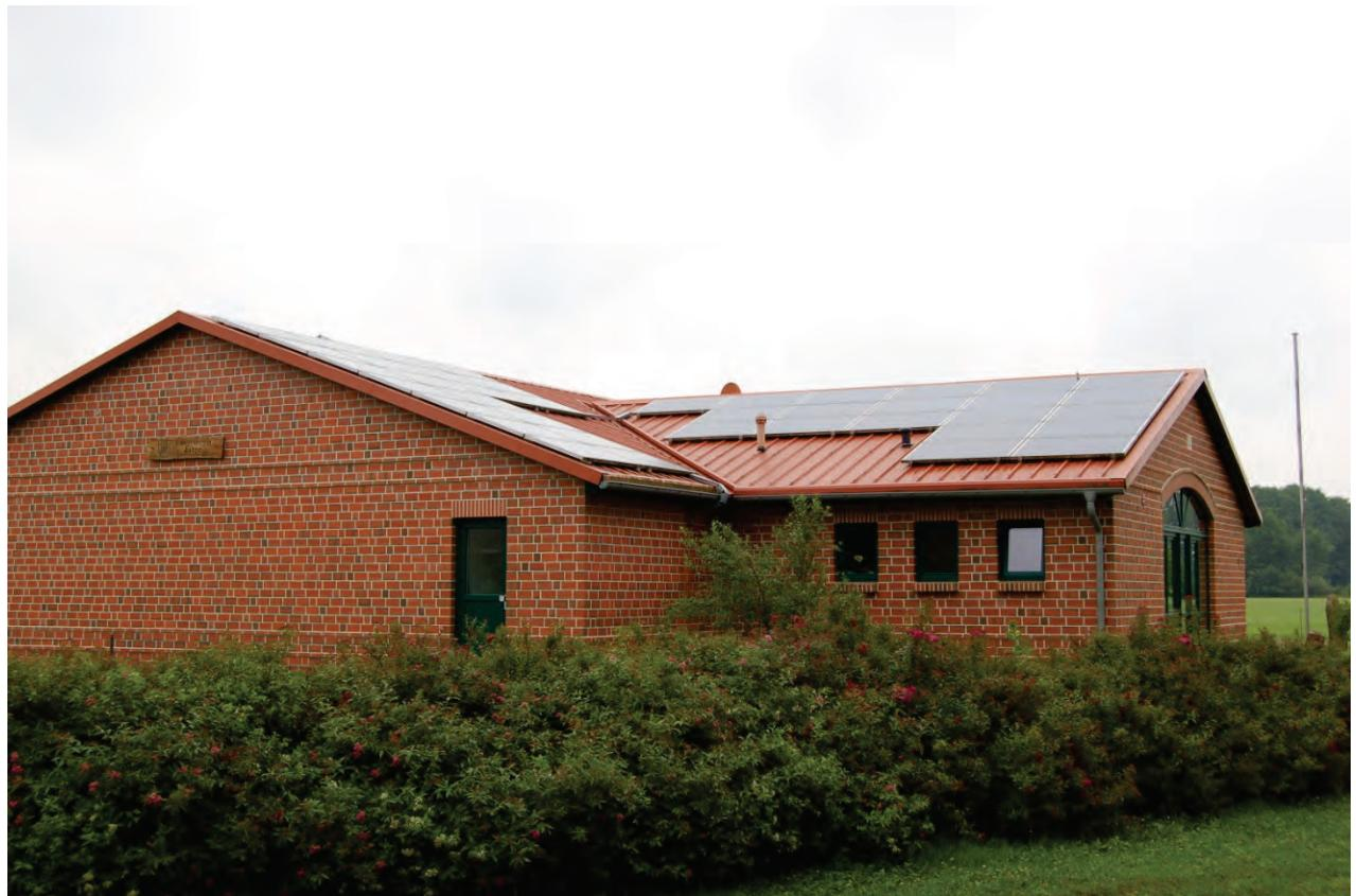
Die Anlage erzeugt im Mittel 860 KWh/kWp pro Jahr bei einem Nutzungsgrad von 83 %. Das bedeutet eine Stromerzeugung 23.735 kWh im Jahr (=863,4 kWh/kWp x 27,49 kWp; das entspricht etwa dem Jahresbedarf von 8 Haushalten). Dadurch werden pro Jahr rd. 21 Tonnen CO<sub>2</sub> vermieden. Pflege und Wartung der Anlage führt der Pächter durch. Der Pachtvertrag verpflichtet den Pächter zum Abschluss einer zusätzlichen Gebäude- und Inventarversicherung wegen der Risiken aus dem Betrieb der Solaranlage.
